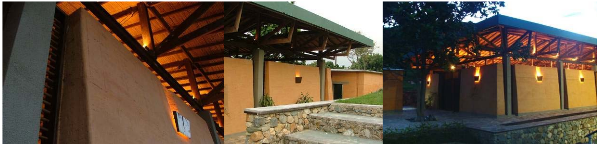
UNAC University Restaurant, Medellín-Colombia. Fundación Tierra Viva 2005. Architect: Jesús Antonio Moreno C.
